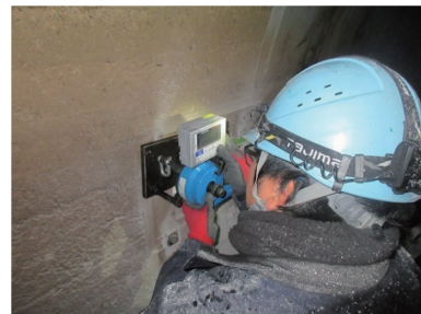
写真9 試験状況 Adhesion test at canal tunnels
