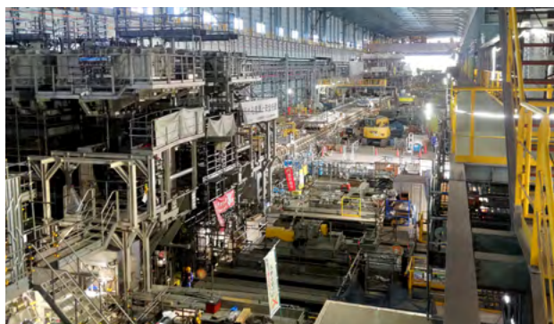
名古屋製鉄所 次世代熱延ライン建設風景
