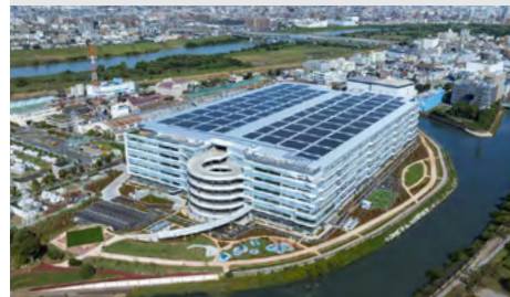
鋼構造技術と豊富な実績で、街と調和する先端物流拠点の創出に貢献 (MFLP・LOGIFRONT 東京板橋)
