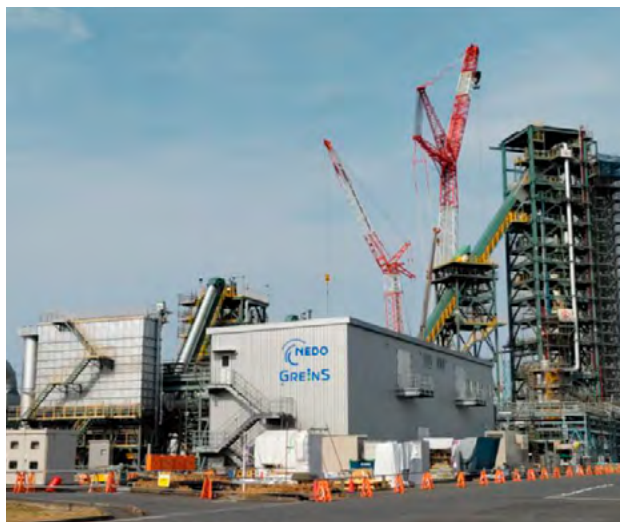
試験シャフト炉操作室（手前）と試験シャフト炉（奥）
