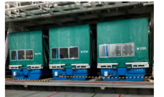
大型エレベーター (一度にロールトレーラー3台)
