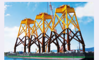
洋上で風車を支えるジャケット式基礎
