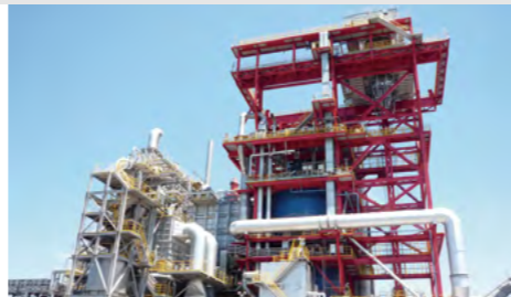
コークスの熱エネルギーを回収し製鉄所からのCO 2 排出量削減に貢献する、コークス乾式消火設備(CDQ)
