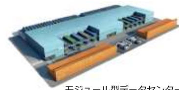
モジュール型データセンター 想定ベース図 (株)NTTファシリティーズ提供)
