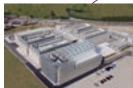
「北九州データセンター」
