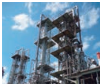
ジビニルベンゼン製造設備
