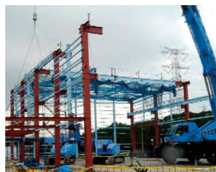
【研究所 施工状況】
