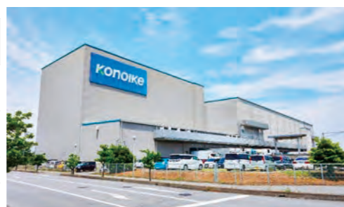
冷凍冷蔵倉庫外観：写真提供 鴻池株式会社
