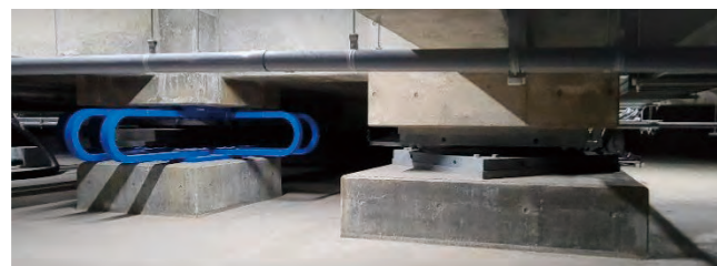
【上部RC取合いの取付状況写真 (NS-SSBとの組合せ例)】
