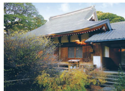
大中寺 表面：アルミナプラスト(AD03) 面積：660m 2 重量：1.2tons 竣工：2006年
