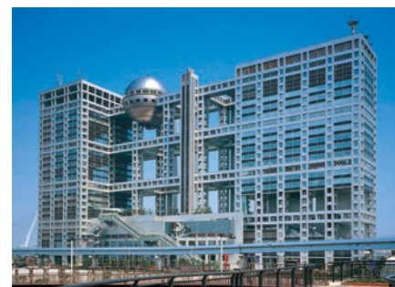
フジテレビ本社ビル/球体展望室 表面：ロールダル(ND10) 光沢 SD3相当(ND10絶版) 面積：2,800m 2 重量：14tons 竣工：1996年
