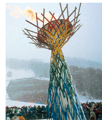
長野オリンピック聖火台 表面：鏡面 板厚：2.0、3.0mm 設計：情報彫刻家/菊竹清文 施工：ティグ 竣工：1998年
