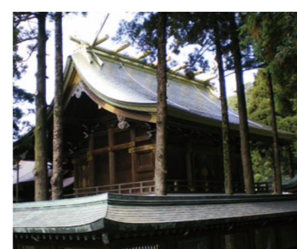
宮地嶽神社 表面：ロールダル(ND20)、 発色：ゴールド 面積：220m 2 重量：0.86tons 竣工：2010年
