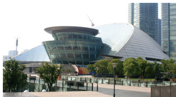
杭州大劇院(中国) 表面：ロールダグ(ND20) 面積：10,000m 2 重量：15tons 竣工：2003年
