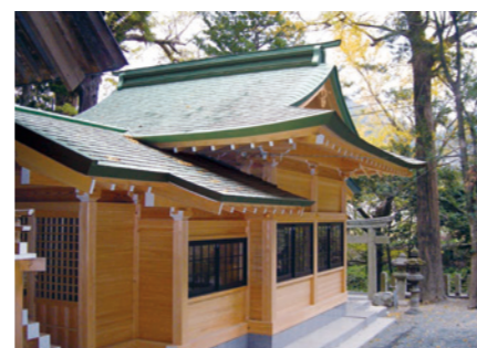
愛鷹神社 表面：アルミナプラスト(AD09)、発色：緑青 面積：440m 2 重量：0.4tons 竣工：2006年
