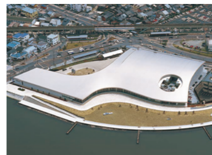
島根県立美術館 表面：酸洗ダル(VP20) VP15相当(PD25NX絶版) 面積：10,000m 2 重量：60tons 竣工：1998年
