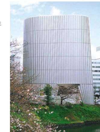
昭和館 表面：アルミナプラスト(AD09) 面積：4,200m 2 重量：56tons 竣工：1998年
