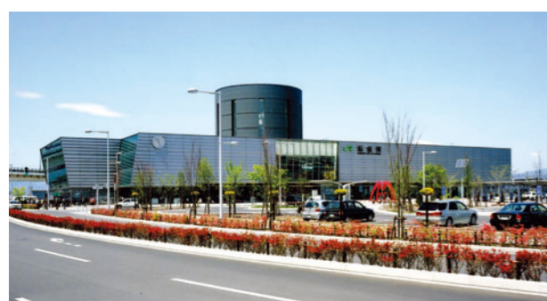
JR函館駅 表面：ロールダグ(ND20) 面積：1,000m 2 重量：7tons 竣工：2003年
