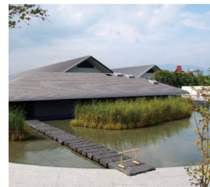
佐川美術館/茶室(楽吉左衛門館) 表面：アルミナプラスト(AD03) 面積：400m 2 重量：1tons 竣工：2007年
