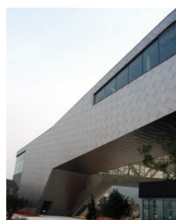
合肥浜湖国際会展中心 表面：ロールダル(ND20) 面積：13,000m 2 重量：21tons 竣工：2011年
