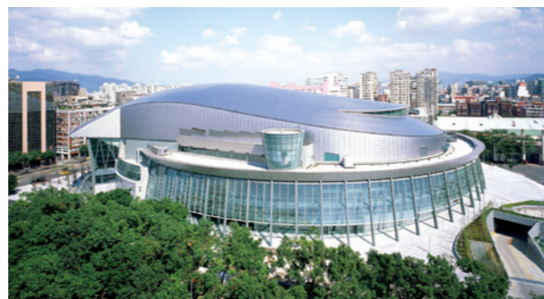
Taipei Arena(台湾) 表面：ロールダグ(ND20) 面積：20,000m 2 重量：50tons 竣工：2005年
