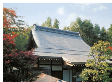
光悦寺/本堂 表面：アルミナプラスト(AD03) 面積：700m 2 重量：1.2tons 竣工：1997年
