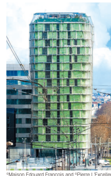
M6B2 Tower of Biodiversity 場 所：フランス/パリ 設 計：エドワード・フランソワ 竣 工：2016年 製 品：Hyperbeta(緑発色) 製品厚：0.4mm
