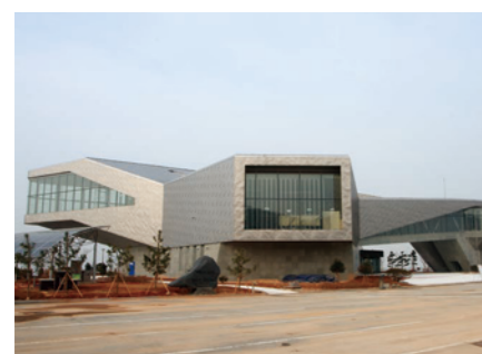
セマングムエキシビジョン センター 表面：ロールダル(ND20) 面積：4,300m 2 重量：10.4tons 竣工：2011年
