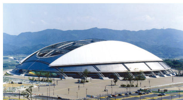
大分スポーツ公園スタジアム 表面：ロールダグ(ND20) 面積：32,000m 2 重量：80tons 竣工：2001年
