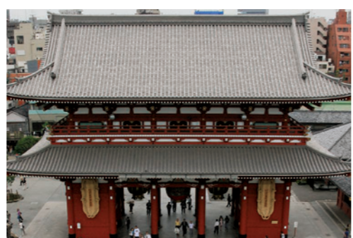
浅草寺宝蔵門 表面：アルミナプラス(AD03, AD06) 面積：1,000m 2 重量：8tons 竣工：2007年
