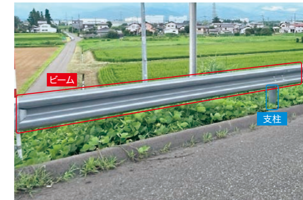
■ (参考) 高速道路におけるガードレールの使用例
