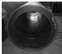
コンクリート打設前
