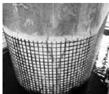
CFRPグリッド設置
