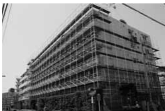
ネオ・ダーウィン 安全で組立解体がスピーディな、新世代の緊結式足場
