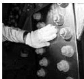
チタン箔シート貼付け
