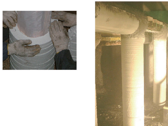
写真1 VFリング施工状況 Vacuum form ring under construction
